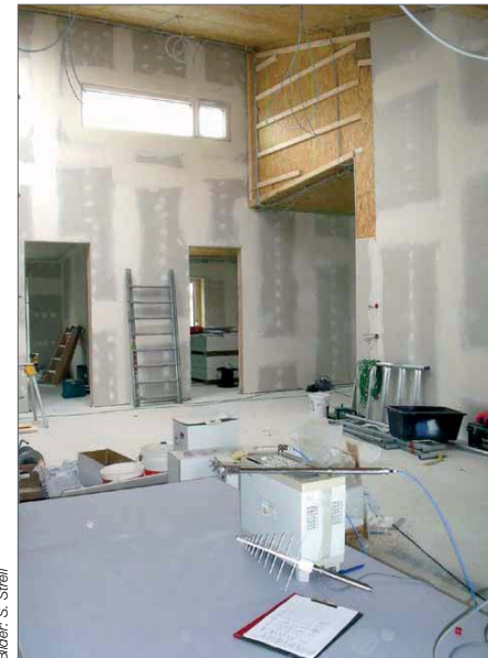
Hochfrequenz-Spektralanalysator zur Kontrollmessung der Abschirmung im Kita-Rohbau
