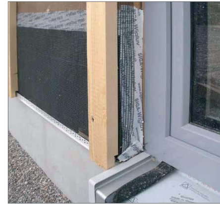
Das zur Abschirmung in der Kita verwendete Carbonfasergewebe wird aus Gründen des Personen- und Sachschutzes geerdet.
