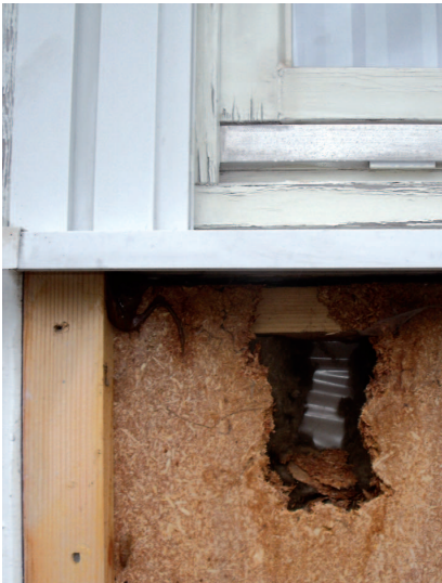
Geöffnete Außenwand: Deutlich erkennbar ist die äußere Spanplattenbeplattung, hinter der sich die Mineralfaserdämmung befindet
