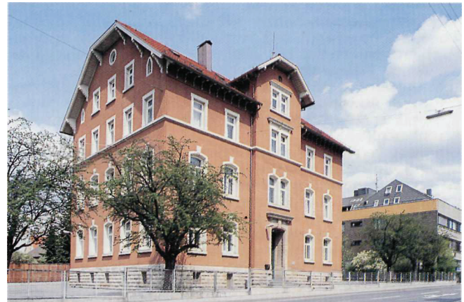
Trotz hoher Emissionsbelastung bedingt durch die Lage an einer Hauptverkehrsstraße zeigen die Fassadenflächen selbst nach 20 Jahren weder Verschmutzung noch Farbtonveränderung.
