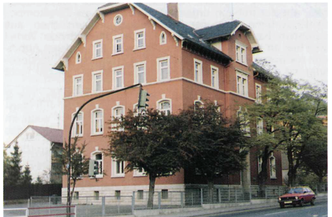
Das Schulgebäude nach der Sanierung 1976 mit BEECK-Silikatfarben.
